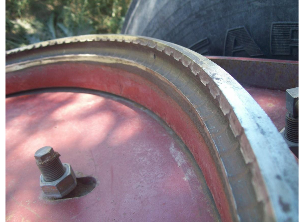
Detalle aro giratorio inferior pista de bolillas y deformación por desprendimiento (fuente: Ing. Luis M. Arrién)
